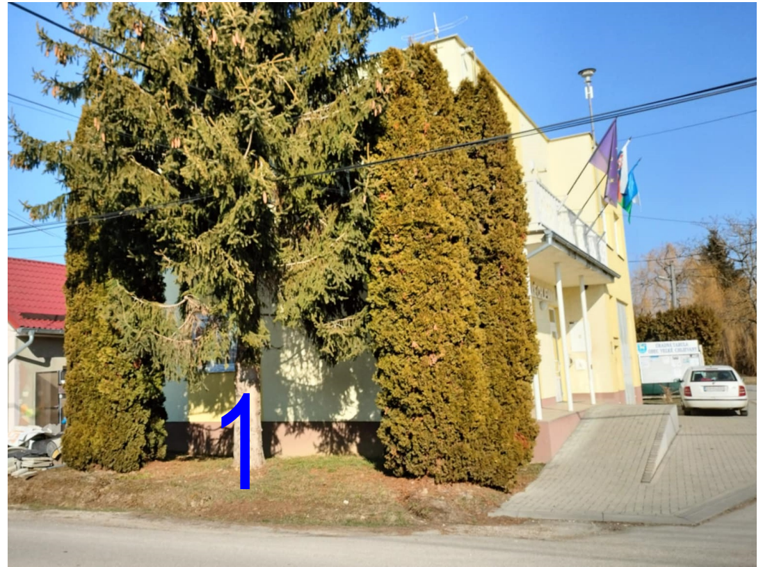
1 Plocha s nefunkčným rigolom, kde sa plánuje terénna depresia t.j. Dažďová záhrada s vegetačnou zónou a vodozádržnými nádobami vedľa budovy Obecného úradu s bezbariérovým vchodom.
